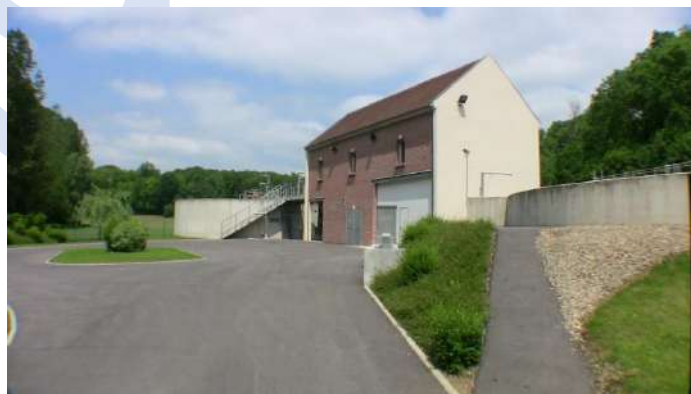
Station d'épuration d'Ullly Saint Georges
