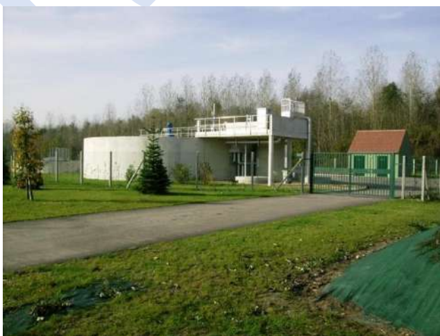
Station d'épuration de Hondainville
