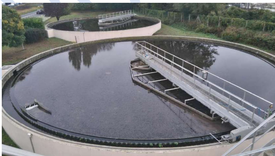
Station d'épuration de Villers sous Saint Leu
