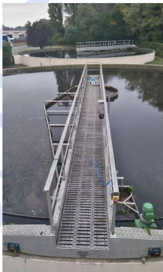
Station d'épuration de Villers sous Saint Leu
