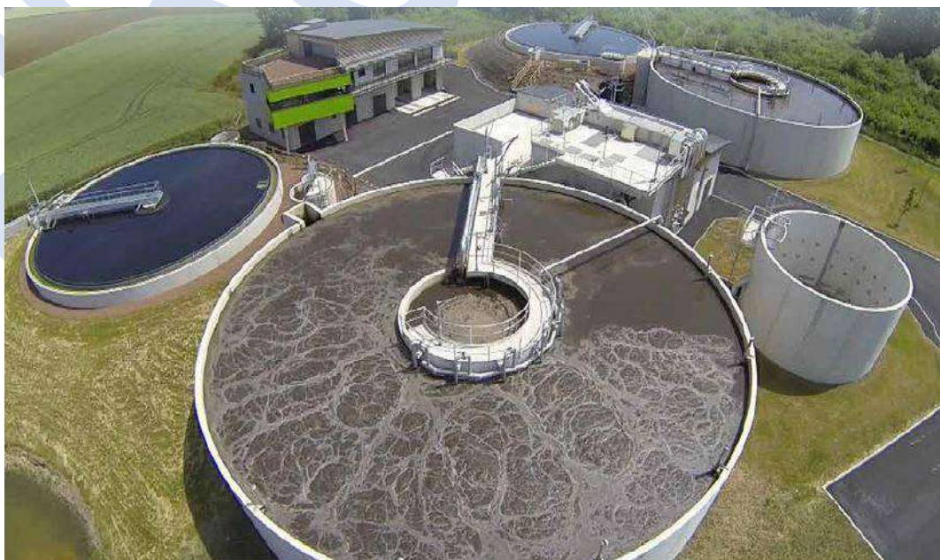
Station d'épuration de Hermes
