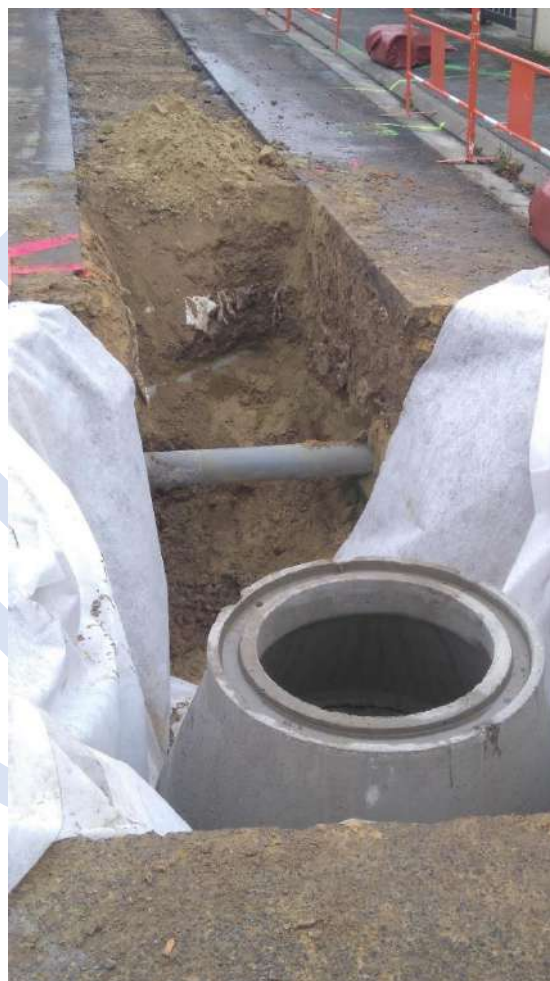
Travaux à Balagny sur Thérain
